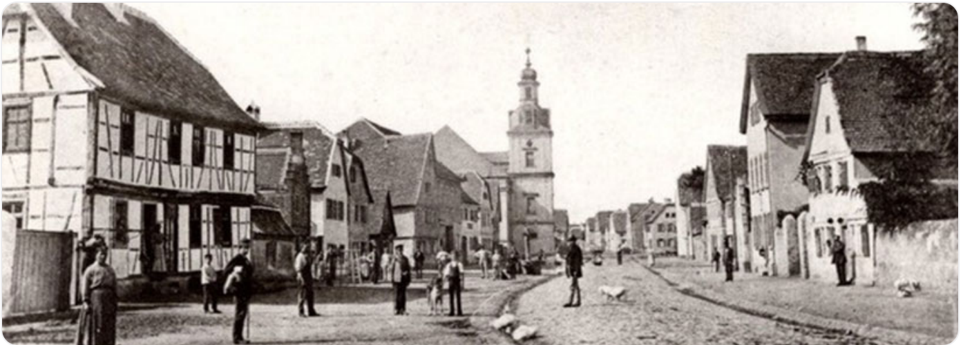
Historische Aufnahme mit Blick auf die Stadtkirche
