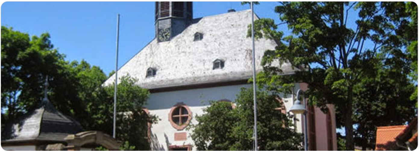
Evangelische Kirche in Bauschheim
